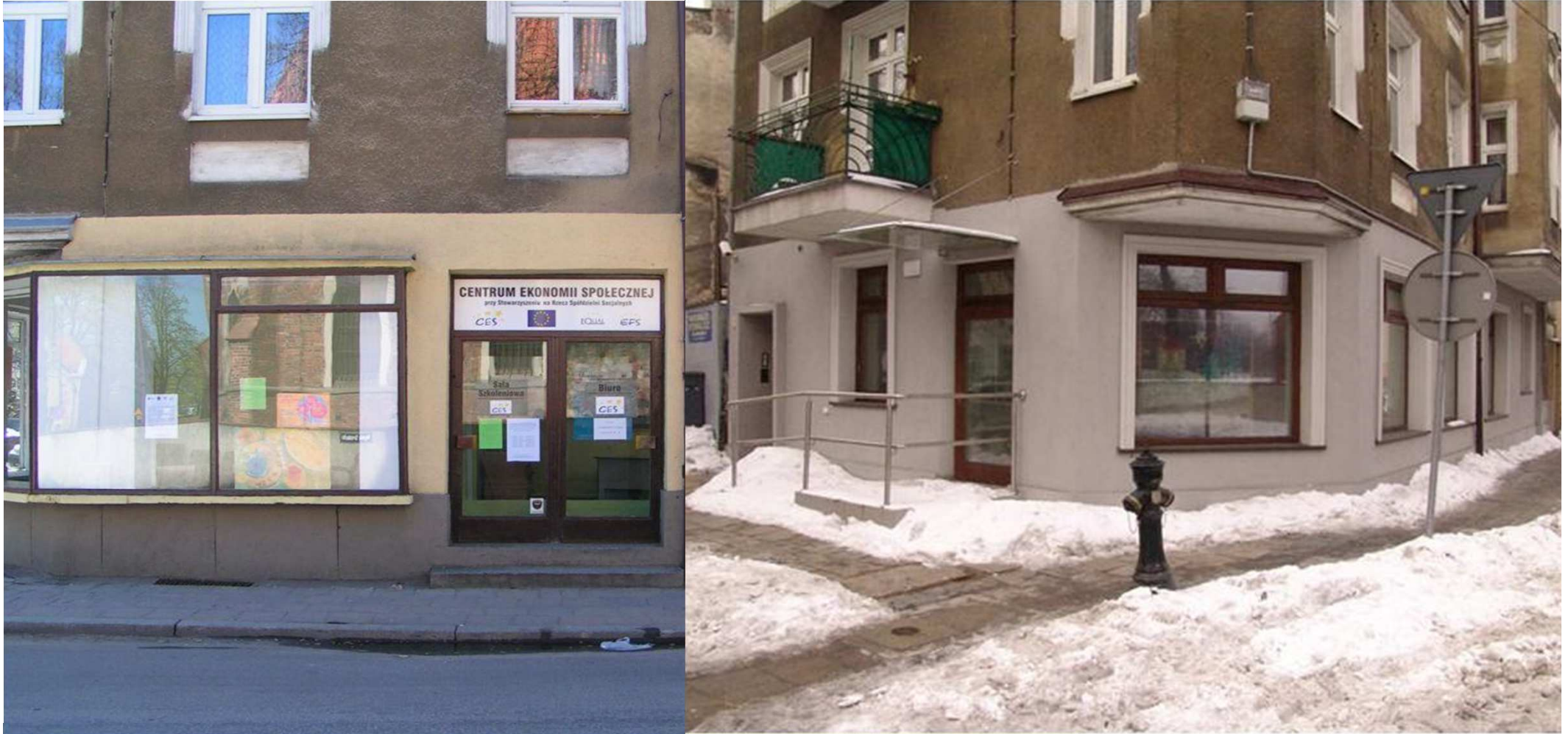
Remont lokalu użytkowego na Śródce przy ulicy Rynek Śródecki 3 (finansowanie: M. Poznań, 2009)
